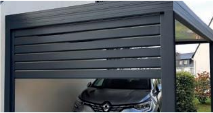
Claire voie lames trapèzes 160 x 25 mm espacé de 25 mm
