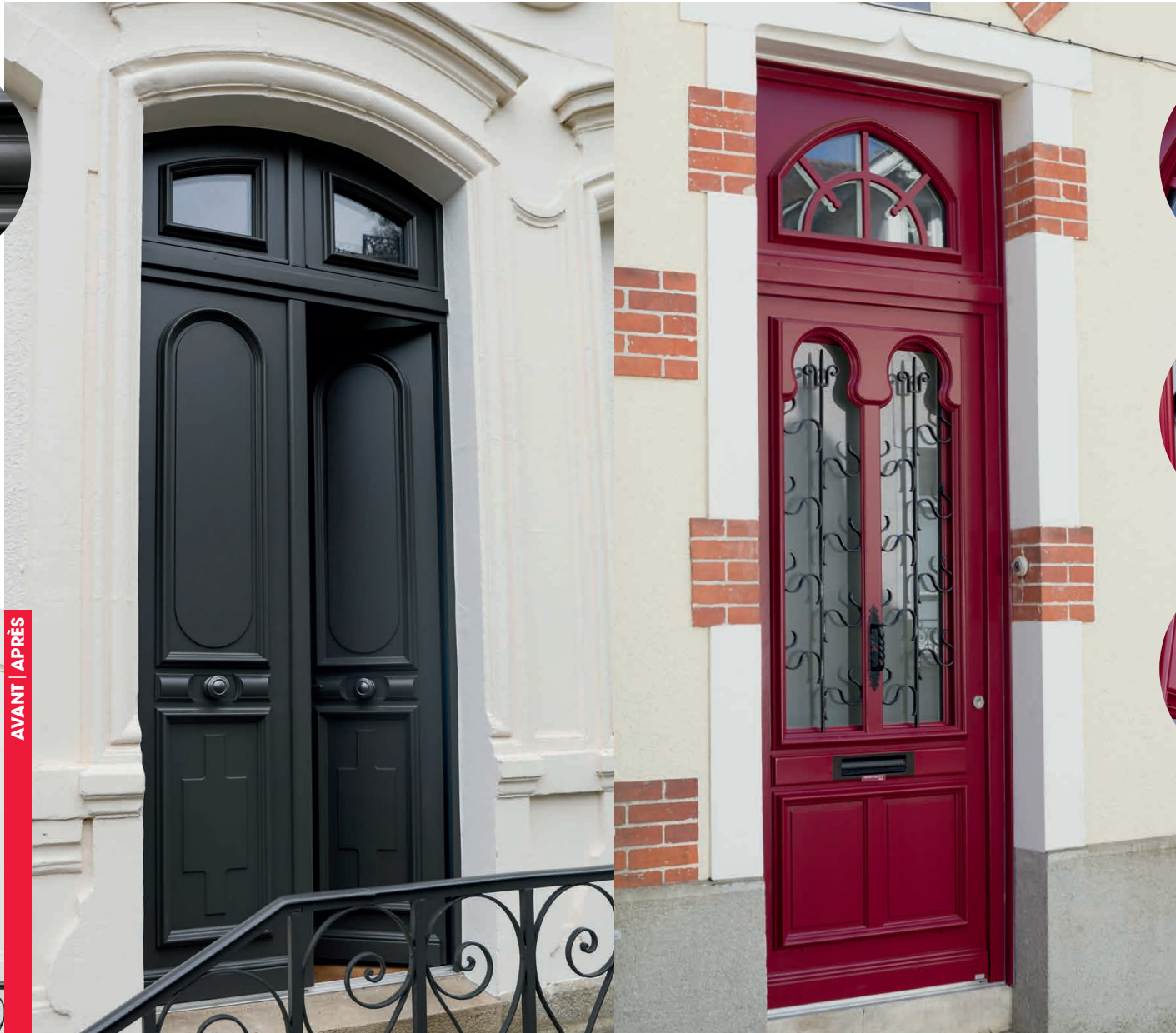
H 3100 : 2480 + 620 imposte / L 1260 : 630 x 2. Le projet a été réalisé pour gagner en isolation et en sécurité, tout en respectant l'architecture du bâtiment. La porte a été créée à partir de photos de l'ancienne.
